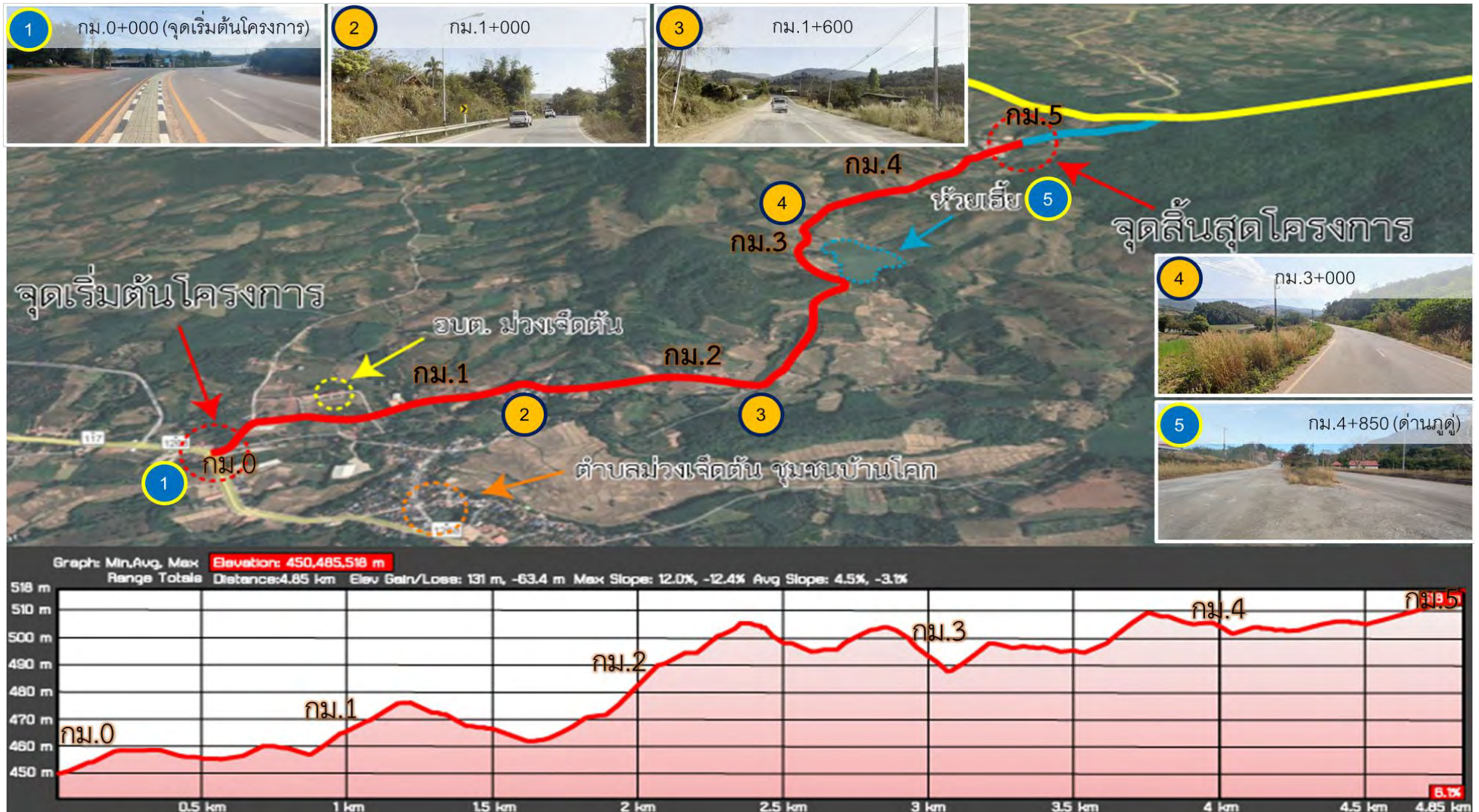
รูปที่ 8-3 สภาพแนวเส้นทางถนนสายบ้านม่วงเจ็ดต้น-ชายแดน สปป.ลาว (ถนนเดิม)
