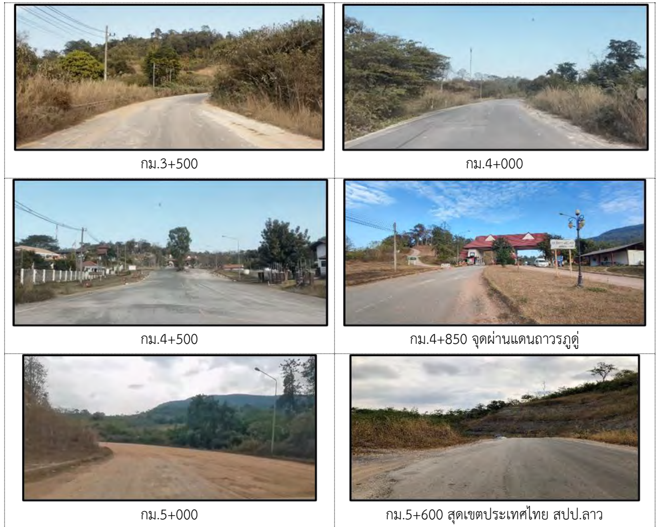
รูปที่ 8-2 สภาพทั่วไปตามแนวเส้นทางโครงการ (ต่อ)
