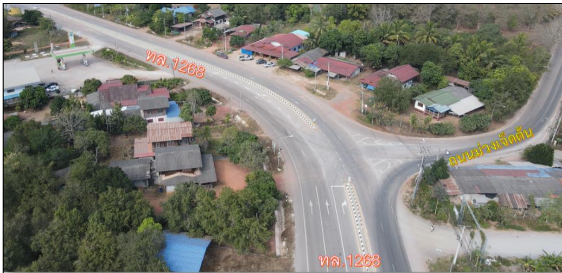
รูปที่ 7-1 สภาพลักษณะของจุดตัดทางแยก
